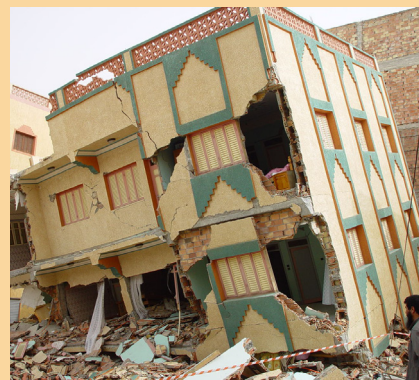
Ein geschädigtes Haus durch das große Erdbeben in Marokko 2004
