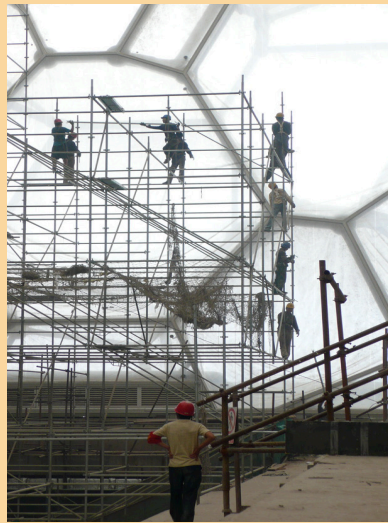
Bauarbeiten am Schwimmstadion
